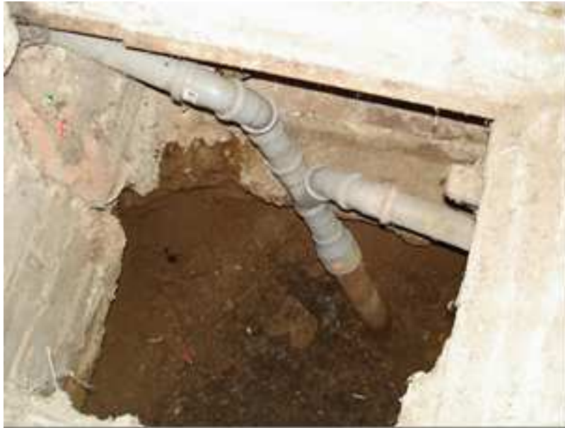
9. att. Kanalizācijas nomainītais stāvvads uz sanmezglēm.
