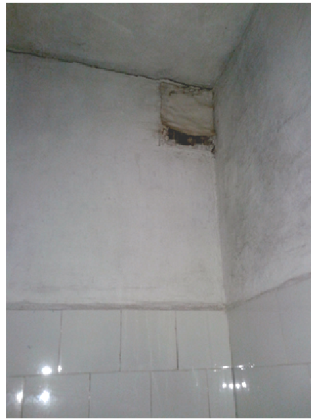
26., 27. att. Dabīgās ventilācijas restītes sienā
