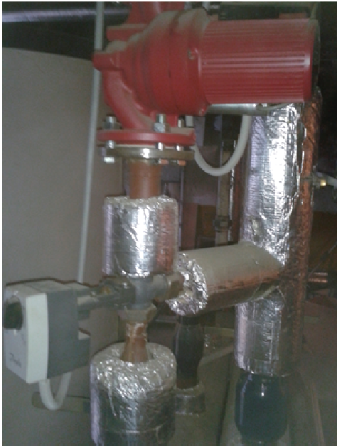
15. att. Apkures sistēmas pieslēgums ar piejaukšanu.
