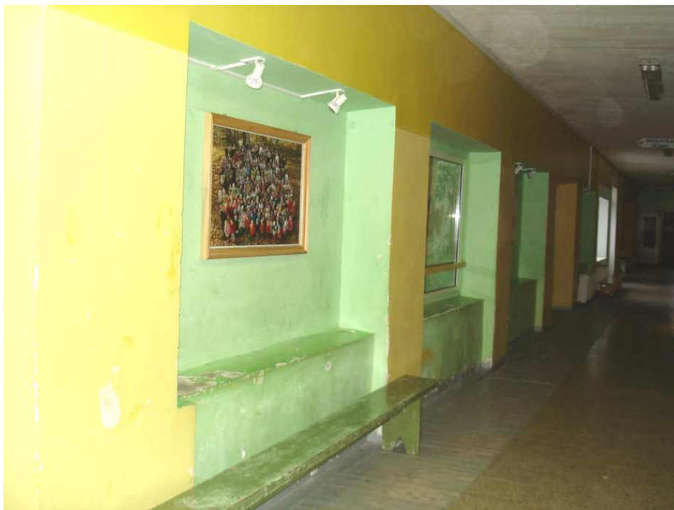
3.att. 1.stāva gaitēņa grīda, sienas, griesti
