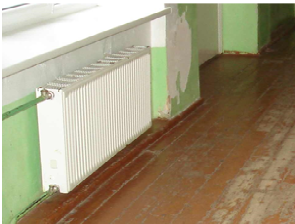
21. att. Mainītais sildķermenis gaitenī
