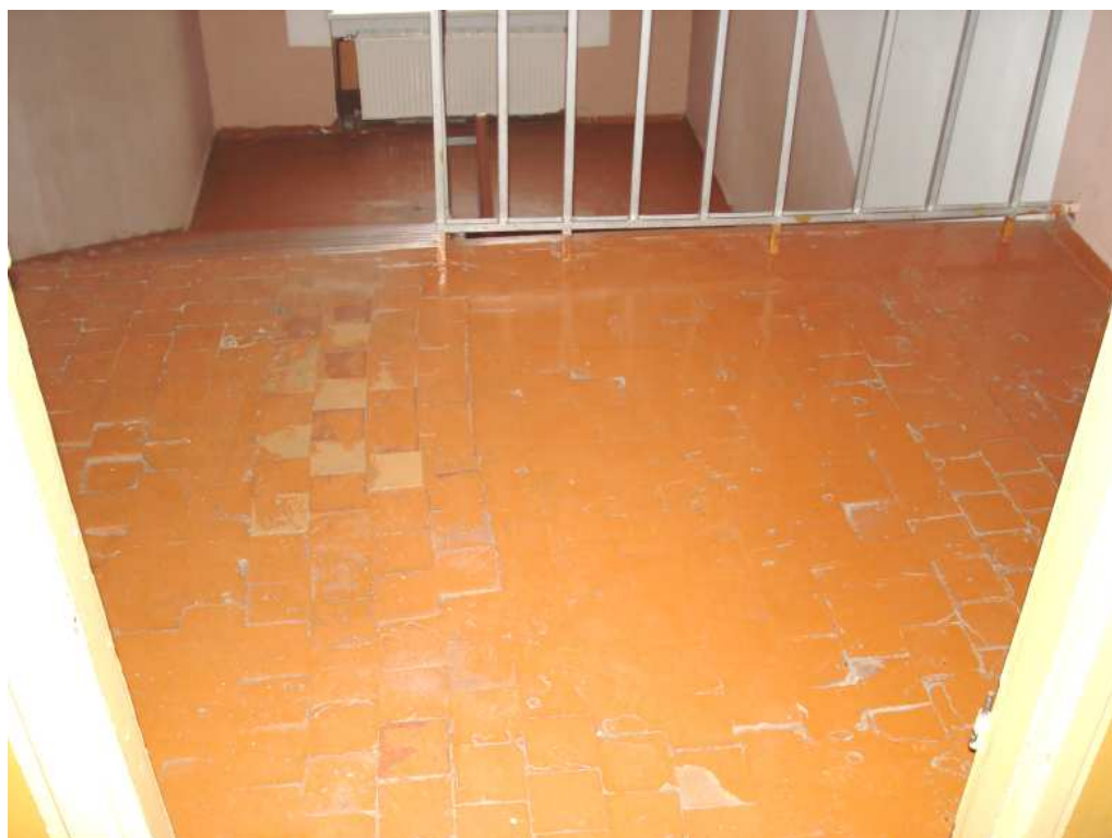
6.att. Skats uz kāpņu telpas laukumu 2. stāvā
