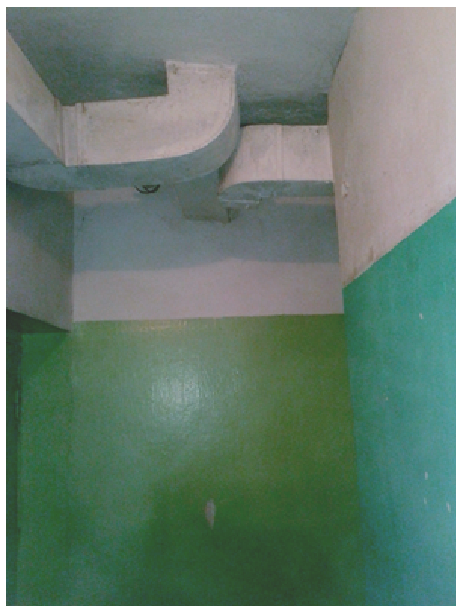
24., 25. att. Sporta zāles sanmezglu un dušu ventilācijas sistēma.
