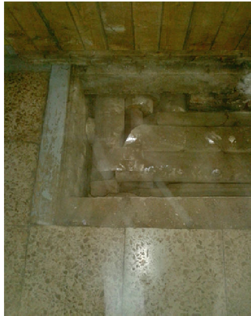
16.att. Apkures sistēmas cauruļvadi kanālā.
