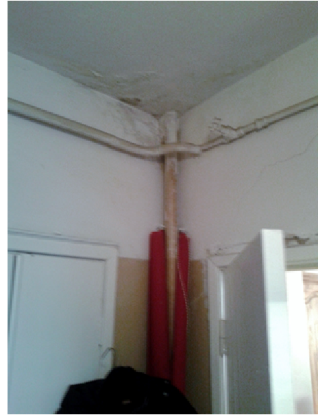
10.att. Esošais čuguna kanalizācijas stāvvads
