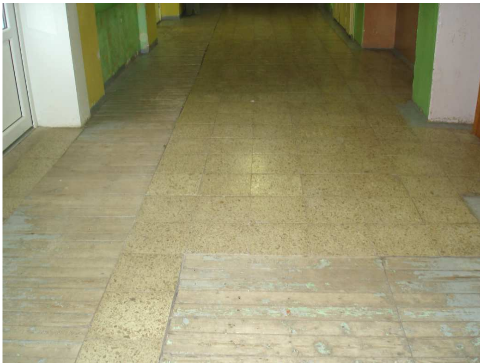
1.att. 1.stāva gaitēņa grīda
