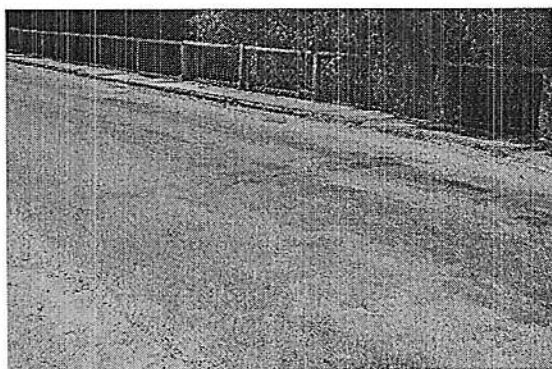
1.19.att. Plaisas segumā virs balsta Nr.4
