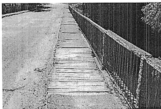
1.21.att. Daļa no ietves pārklāta ar koka klāju
