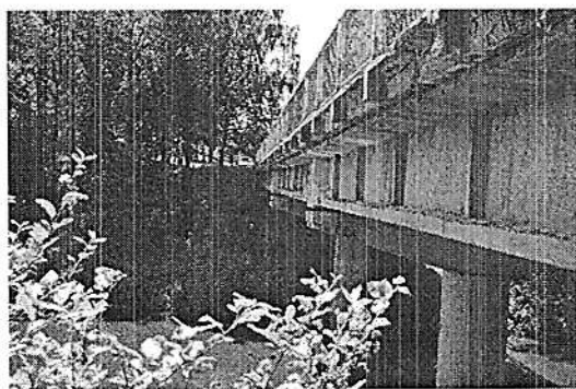
1.24.att. Skats un malējām sijām no augšteces puses
