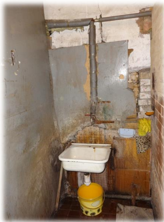
Rīga, Mangaļsalas iela 21 – mazgāšanās telpa
