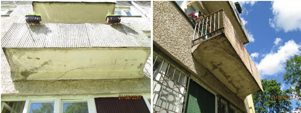
F-12; F-13. Balkona plātņu bojājumi
