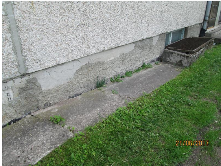
F-5. Nosēdusies betona aizsargmale gar ēku
