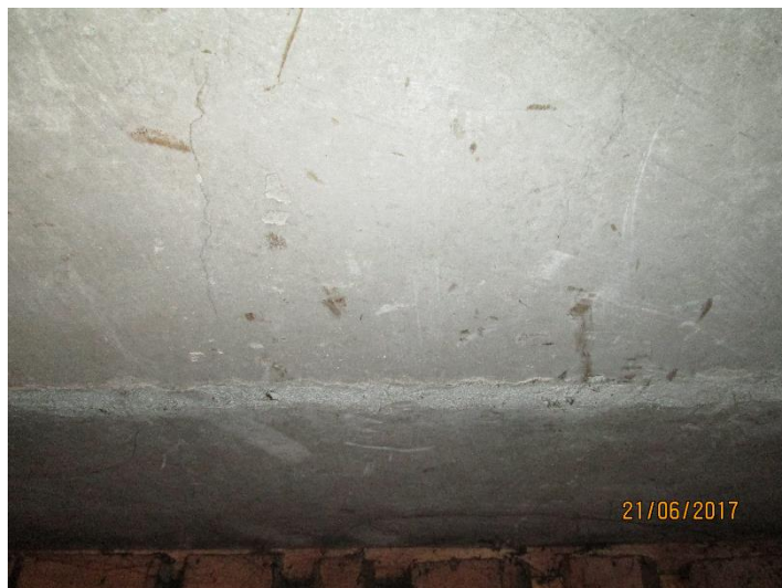
F-7. Plaisiņas pagraba pārseguma dzelzsbetona gatavplātnē
