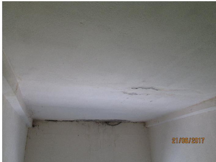
F-9. Mitruma piesātinājuma bojājumi pārsegumā un kāpņu telpas sienā
