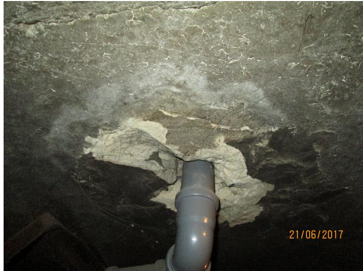
F-8. Patvarīgi izveidots atvērums dzelzsbetona plātnē inženiertīklu izvadīšanai
