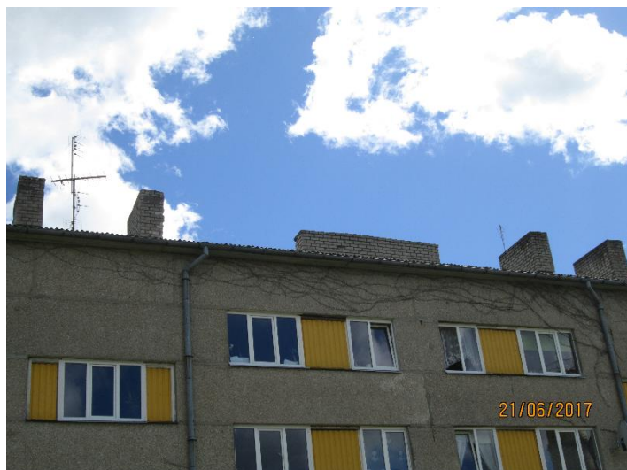
F-17. Vēdināšanas kanāli virs jumta
