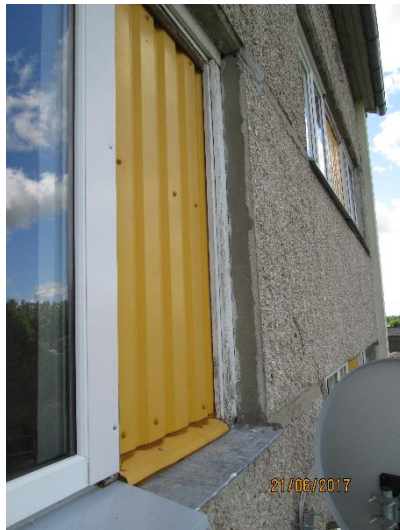
F-6. Nekvalitatīvi izveidots logailas aizpildījums
