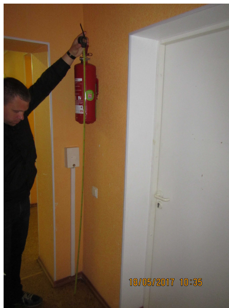
Fotofiksācija Nr.12 Ugunsdzēsības aparātu atrašanās vieta nav apzīmēta un tie atrodas par augstu
