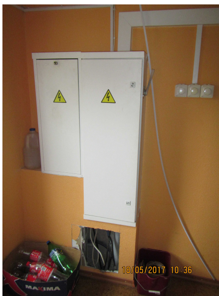
Fotofiksācija Nr.10 Inženiertīklu šahtai nenosegts atvērums
