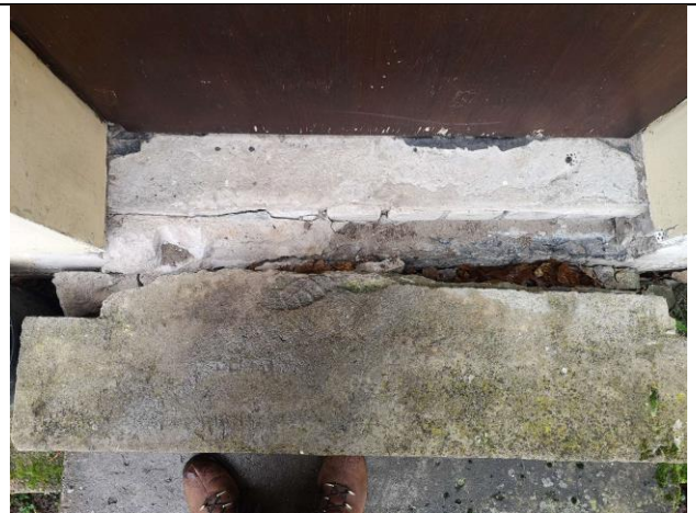
4.9.4 ēkas austrumu puses betona lievenis
