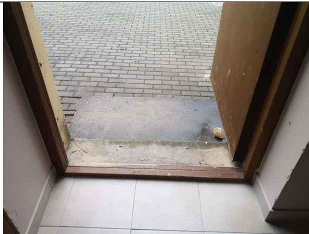
4.9.3 ēkas rietumu puses betona lievenis
