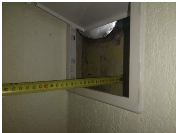
4.2.3 caur lūku izdevās nomērīt attālumu no mūra sienām līdz loksnei – 15cm
