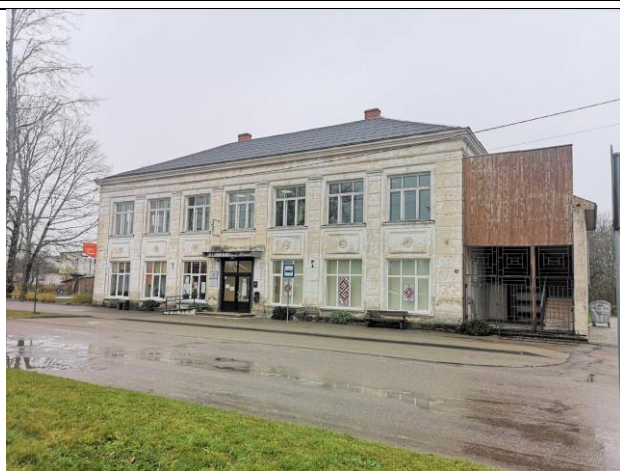
4.19.1 austrumu fasāde. Galvenā fasāde
